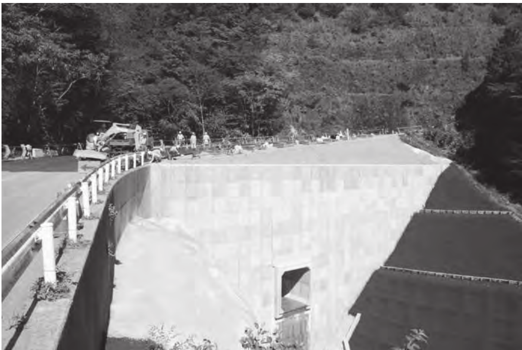
復旧した林道東津野城川線
