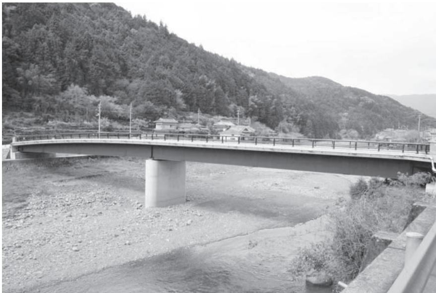
完成した馬関橋
