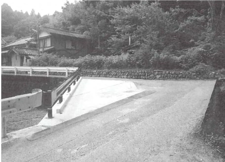
緊急車両も通行しやすく改良された町道
