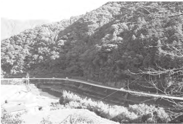
崩落が心配される国道197号(通称滝山付近)
