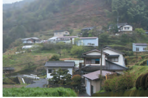
水道が改善される下桑ケ市地区
