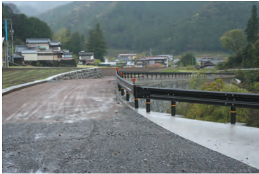
社会資本整備事業による町道整備（久保川東線）
