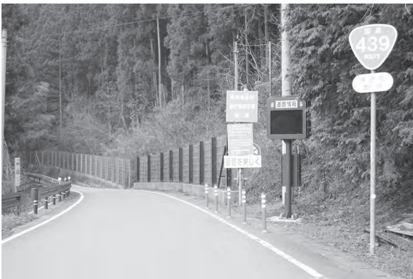
度々通行規制の係る国道439号（北川）
