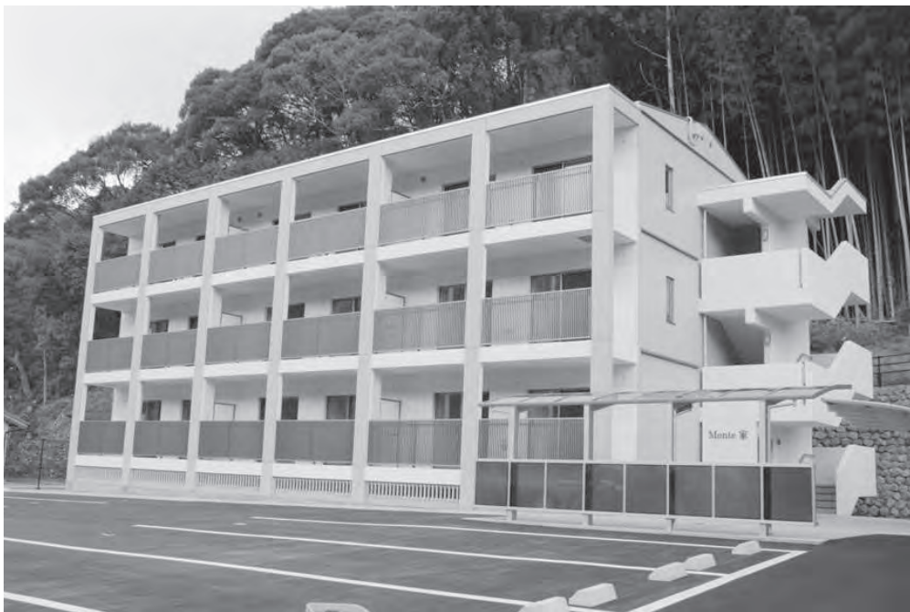
完成した若者定住住宅monte家（姫野々）
