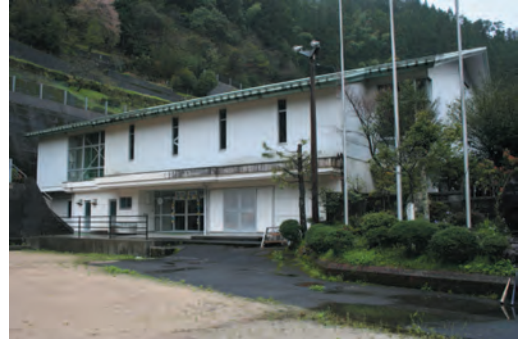
増改築される旧郷小学校
