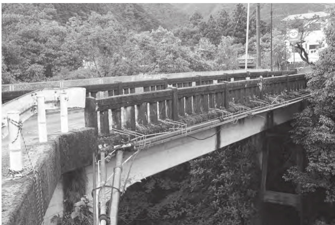
改修される町道船野白河瀬線「黒川橋」
