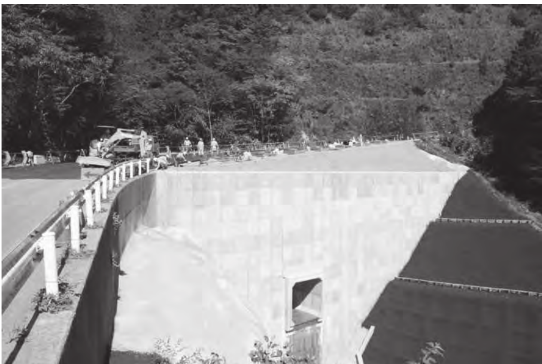
復旧した林道東津野城川線
