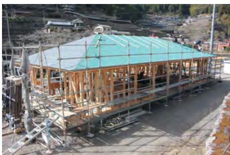
建築中の貝ノ川地区集落活動拠点施設
