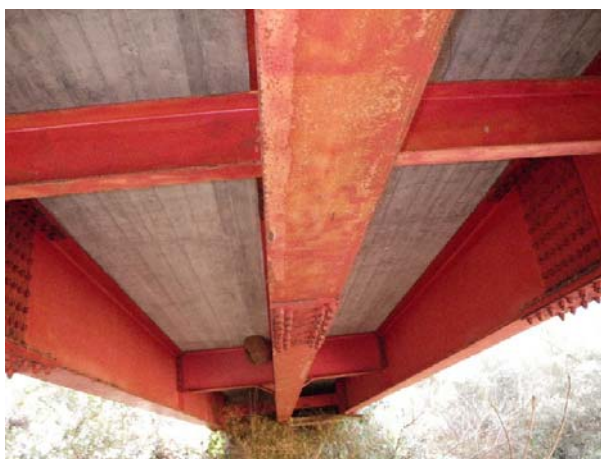
主桁腐食
