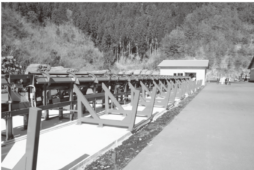
新しく導入された木材自動選木機 全長約 95m
