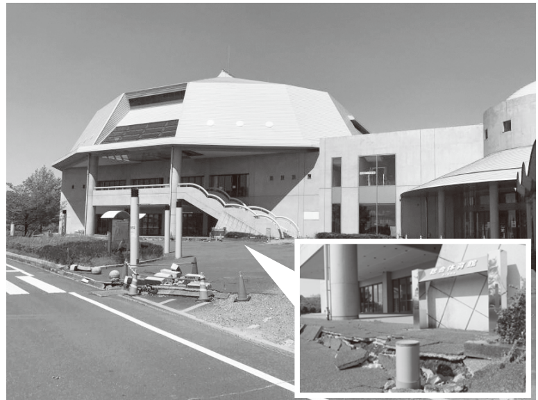
地震の凄さが残る 益城町総合体育館
