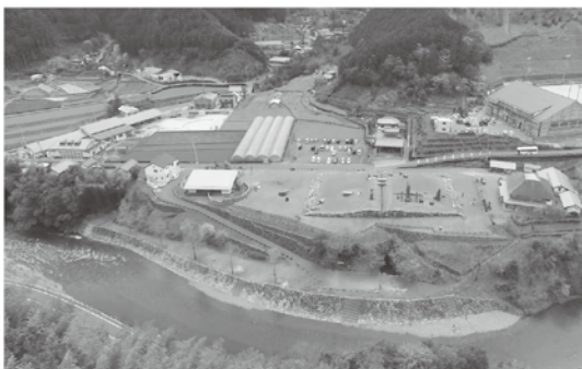
防災拠点施設用地
