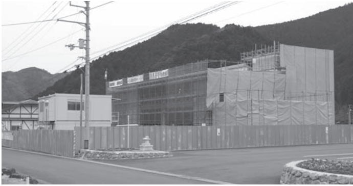
建築中の防災拠点施設
