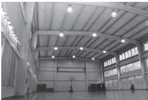
水銀灯照明の既存の施設 (新土居健康管理センター)
