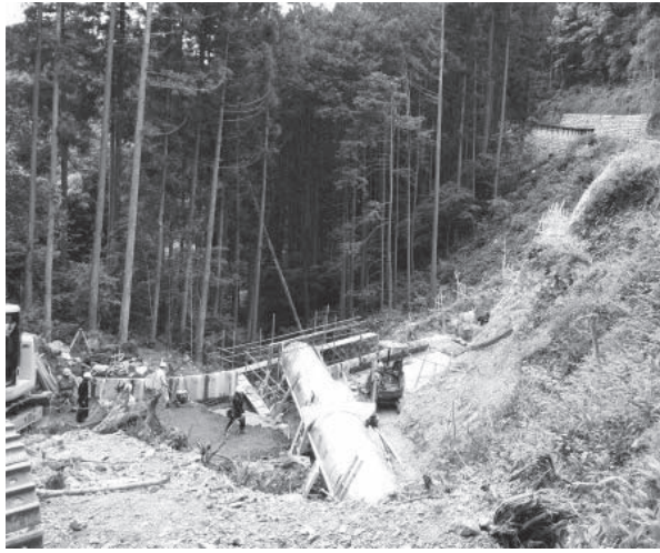
道路改良工事
