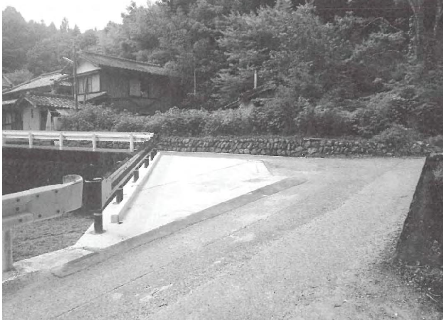
緊急車両も通行しやすく改良された町道
