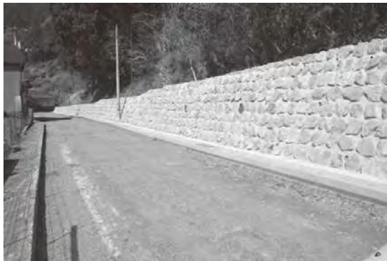
改良が進む町道新田保井川線
