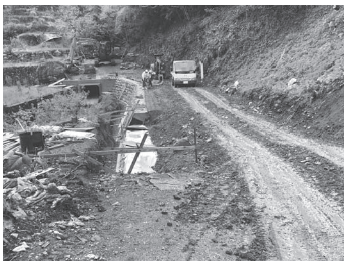
悲願の再着手 (三間川く樺ノ川連絡道)
