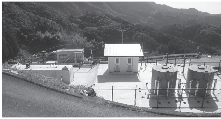
工事中の「樺ノ川簡易水道施設」(浄水場)
