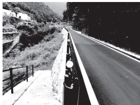
改良された町道 行き違いも楽になった
