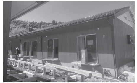
プレハブ仮設と木造仮設。 間取りは同じだが断熱、結露など快適性で大きな差があることも。
