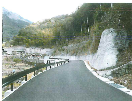
町道の改良（西黒川線）
