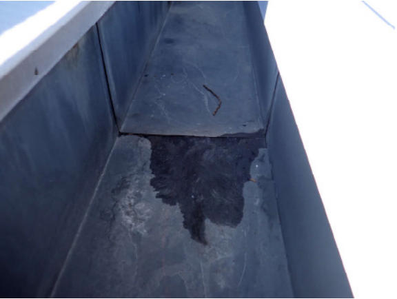
金属屋根谷樋部 ジョイント部
