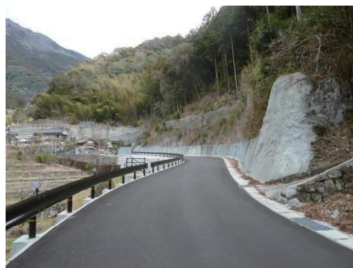
町道の改良（西黒川線）
