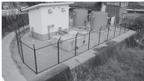
▲工事中の貝ノ川簡易水道（浄水場）
