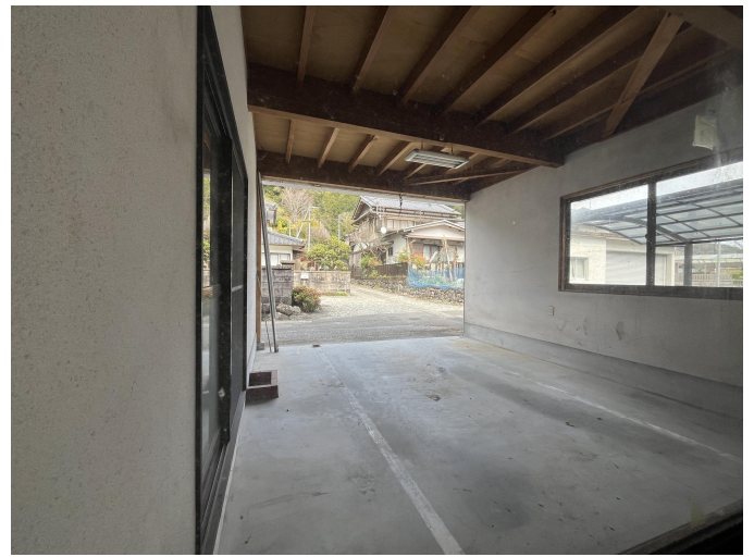
駐車場兼倉庫
